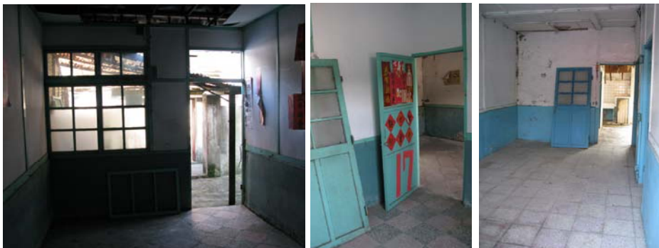
眷村室內現況照片
